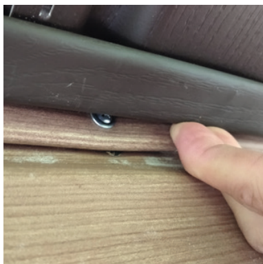
Два самореза закреплены в тело материала. Светлый в J-профиль, под ним черный с потайной головкой.
